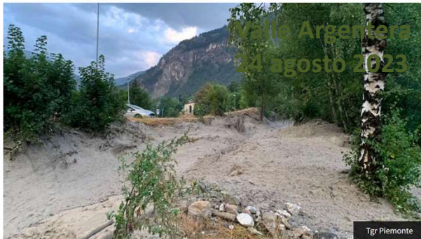
La frana che ha bloccato la via di accesso a Sauze di Cesana
