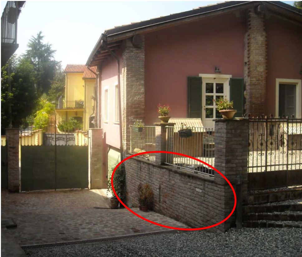
Muretto controterra difforme dal progetto
